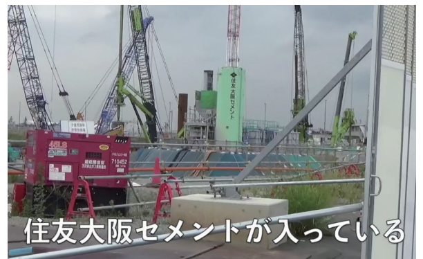
軟弱地盤を固める工事はセメント屋が一番儲かる
