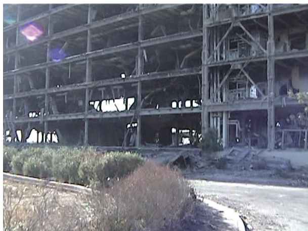
窓ガラスもコンクリート壁も吹き飛んで
