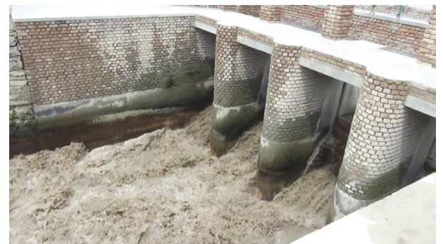
4. 取水口の今。暴れ川の水を見事に引き込んでいる
